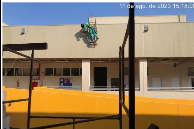
Imagem 8 – Fixação suportes de Cobertura
