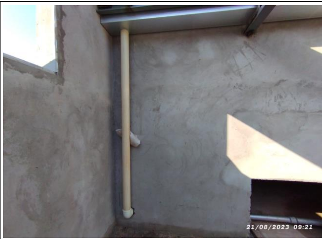
Imagem 11 – Descida das calhas
