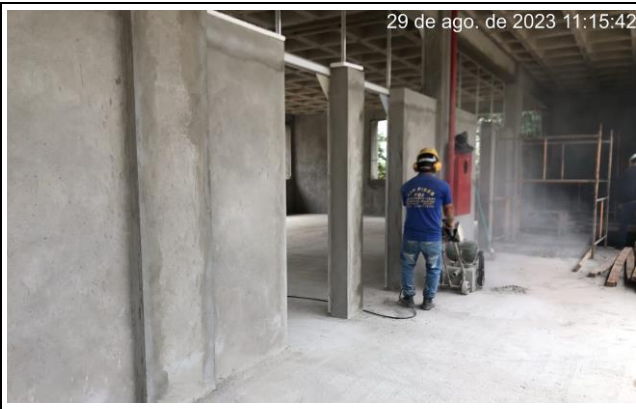
Imagem 17 – Corte de piso
