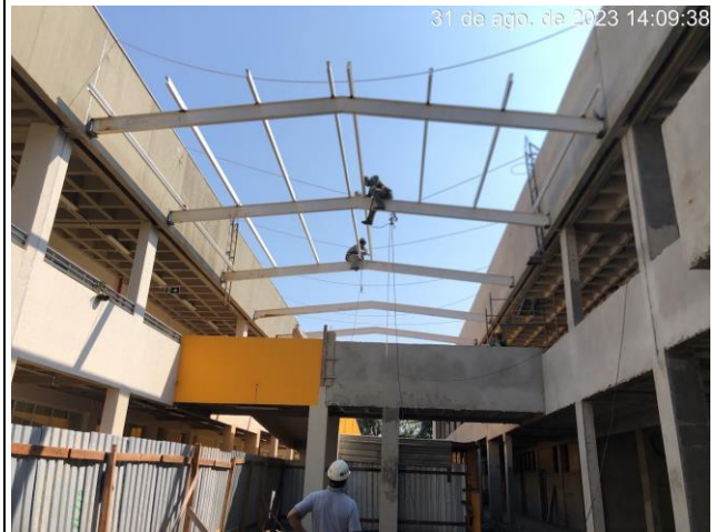
Imagem 20 – Tesouras metálicas (Vão central)
