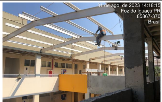
Imagem 18 – Tesouras metálicas (Vão central)
