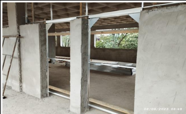
Imagem 6 – Fixação de contramarcos
