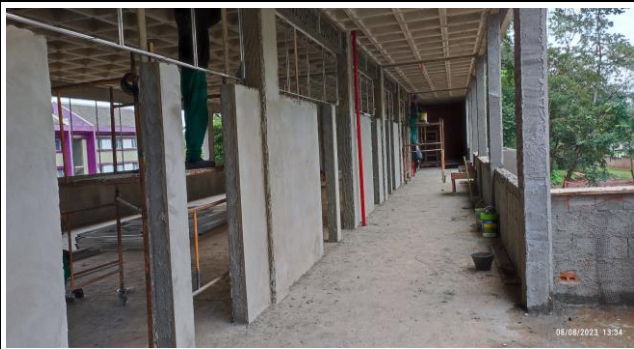
Imagem 5 – Vista geral (piso superior) - instalações, revestimentos e contramarcos de esquadrias.
