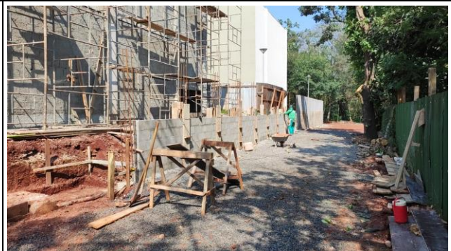
Imagem 14 – Alvenaria - Muro de arrimo
