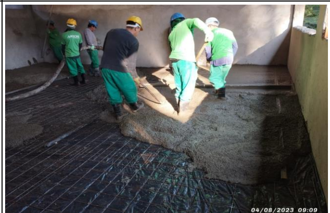
Imagem 4 – Concretagem laje de piso (Térreo)
