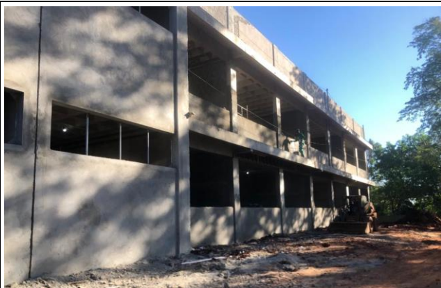
Imagem 1 – Acabamentos externos -Setores B e C
