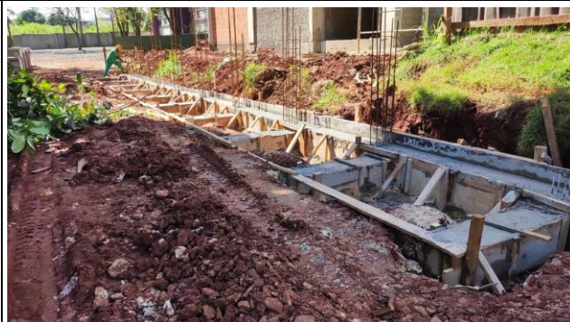
Imagem 10 – Estrutura - muro de arrimo
