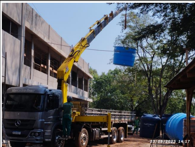
Imagem 15 – Instalação reservatórios superiores
