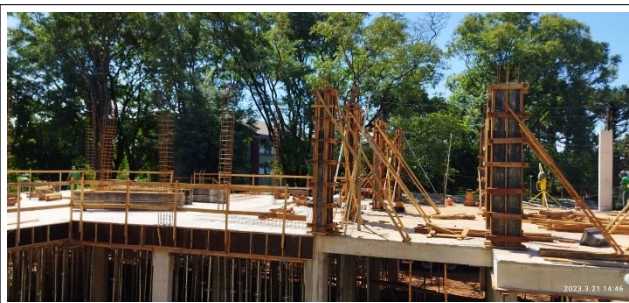
Figura 10 – Armação e forma pilares de cobertura – Setor A
