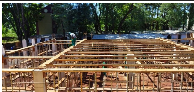
Figura 2 – Formas e armação de vigas e laje Setor B
