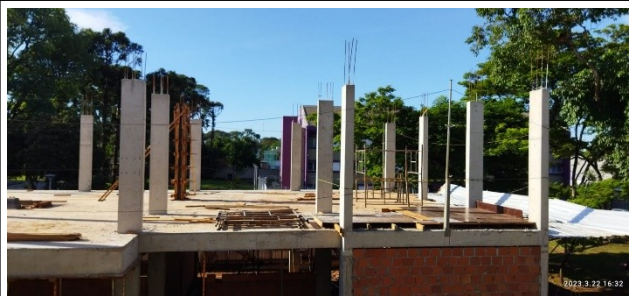
Figura 10 – Armação e forma pilares de cobertura – Setor A
