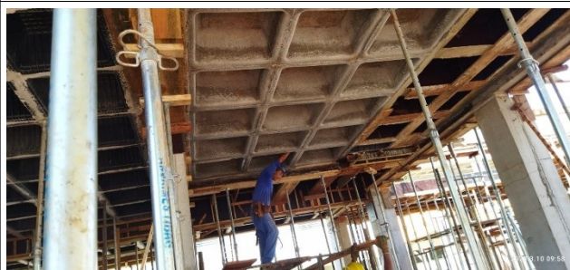
Figura 4 – Formas e armação de vigas e laje Setor B
