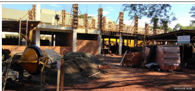
Figura 15 – Vista geral de obra
