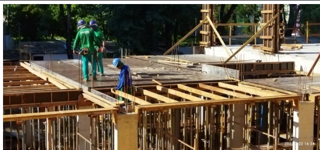
Figura 11 – Formas e armação de vigas e laje – Setor C
