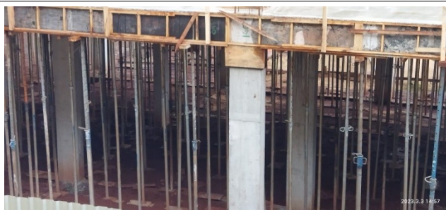
Figura 1 – Pilares finalizados - Térreo Setor C
