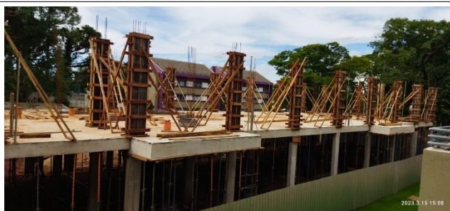
Figura 7 – Armação e forma pilares de cobertura – Setor A
