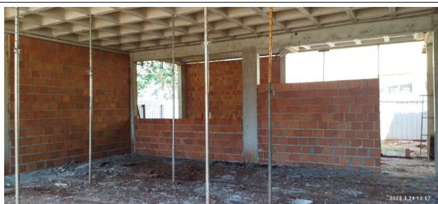
Figura 11 – Formas e armação de vigas e laje – Setor C
