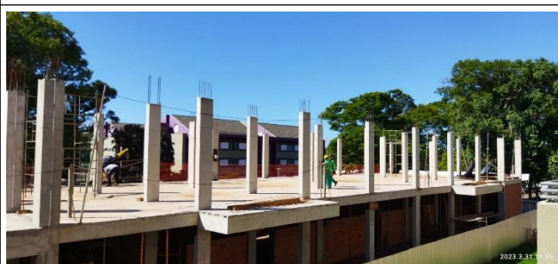
Figura 16 – Pilares de cobertura – vista geral
