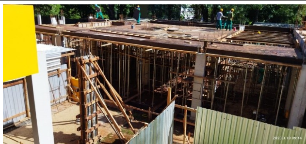
Figura 3 – Escoramento - Setor B Superior
