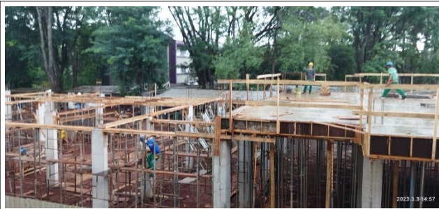
Figura 2 – Formas e armação de vigas e laje Setor B
