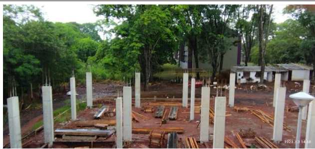
Figura 1 – Pilares finalizados - Térreo Setor C
