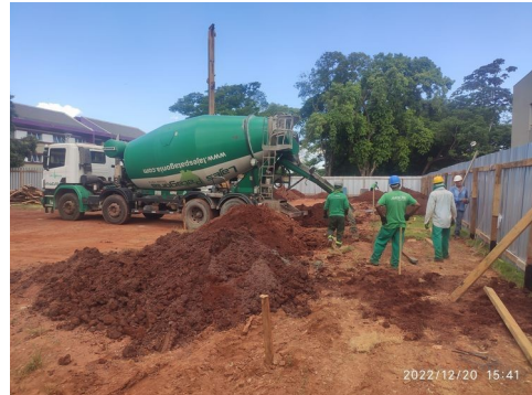
Figura 10 – Concretagem das estacas
