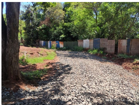
Figura 3 – Pavimentação da via de acesso
