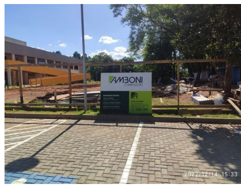
Figura 4 – Colocação de tapume
