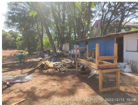
Figura 2 – Limpeza do canteiro
