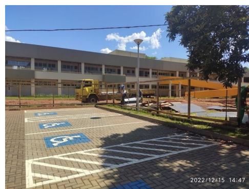
Figura 6 – Cercamento da obra com tapume
