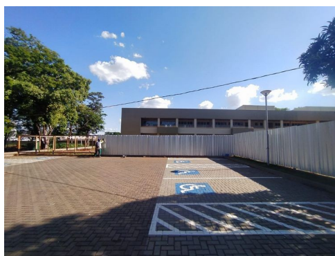
Figura 7 – Cercamento da obra com tapume
