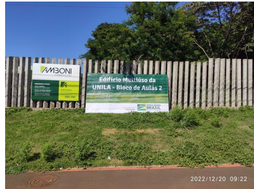
Figura 12 – Instalação da placa de obra oficial
