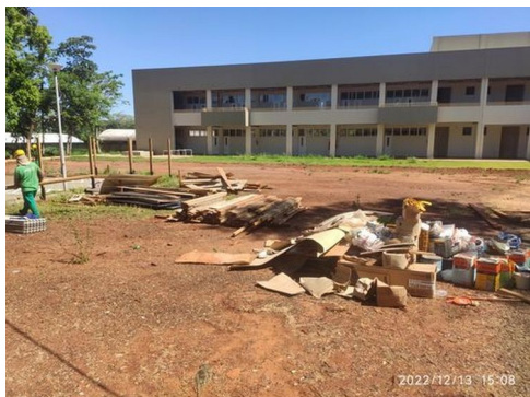
Figura 1 – Limpeza do canteiro e retirada de entulho
