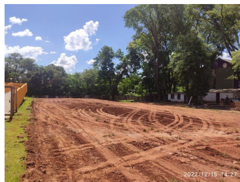
Figura 8 – Terraplenagem do terreno
