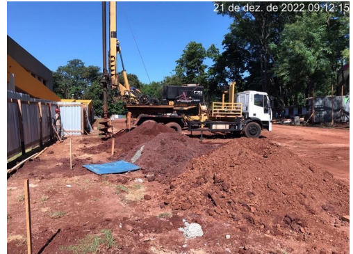
Figura 14 – Perfuração de estacas
