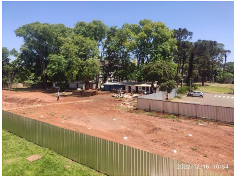
Figura 9 – Locação das estacas com topografia
