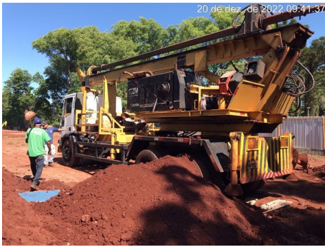
Figura 11 – Locação das estacas
