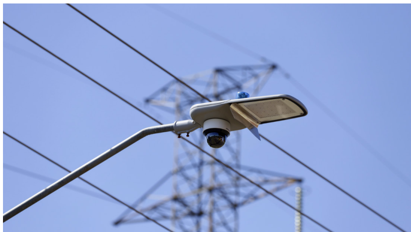
Figura 5 – Luminária inteligente e câmera de segurança com reconhecimento facial acoplada instalada em uma avenida do bairro Itaipu A
