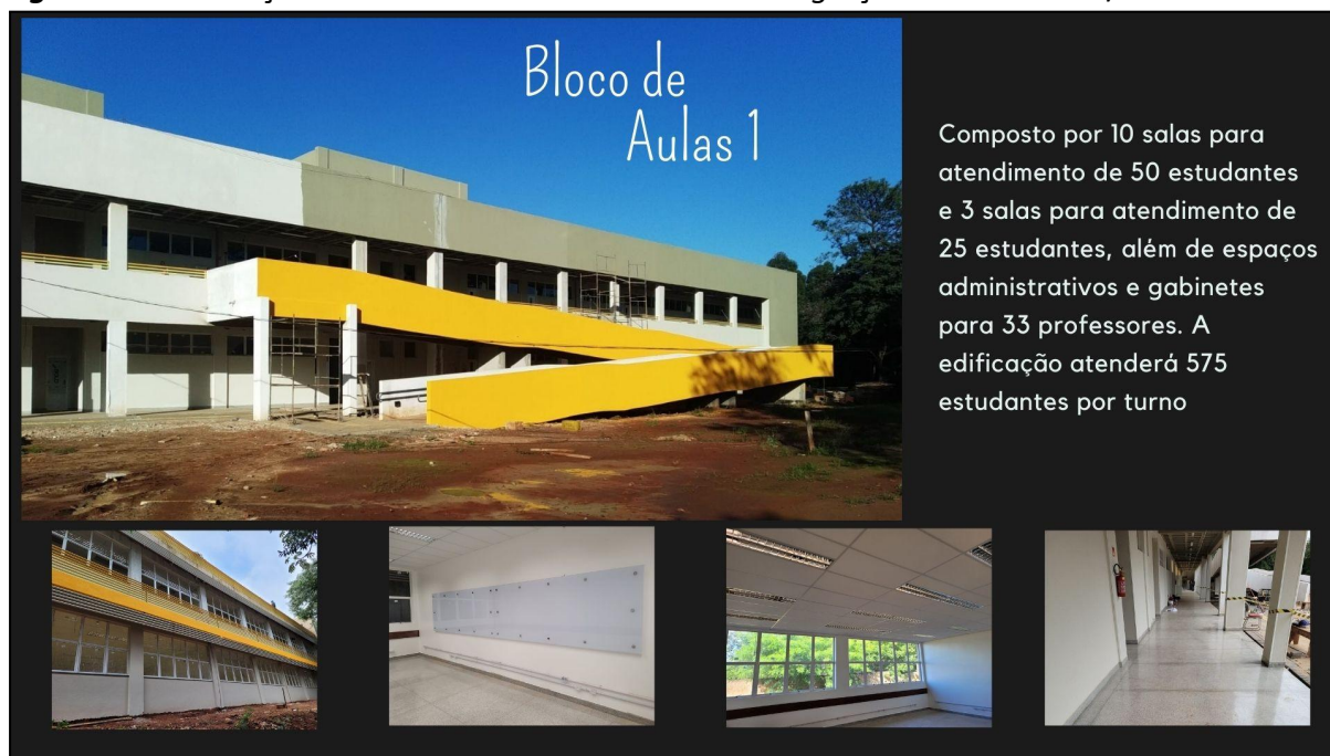
Figura VIII - Execução do Bloco de Aulas 1 - Unidade Integração. Fonte: SECIC/UNILA.
