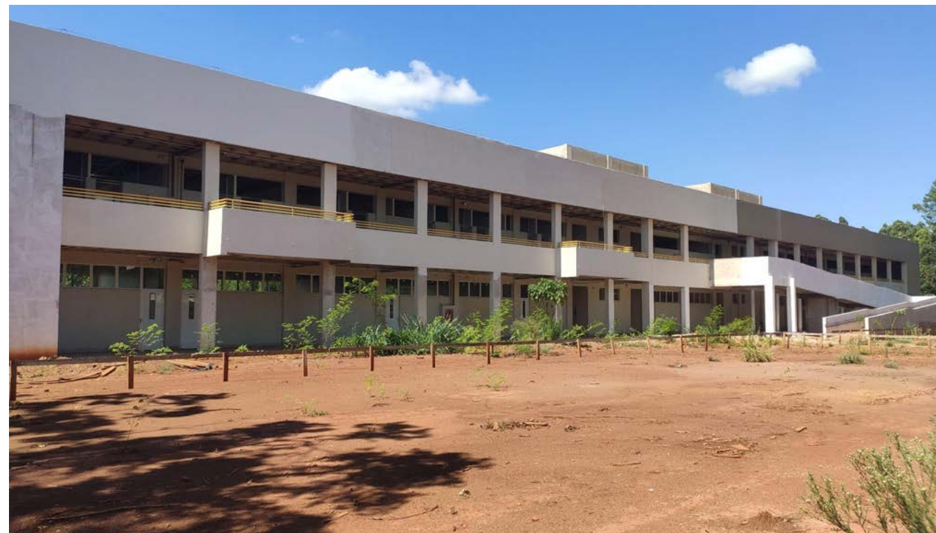
FIGURA 19: FACHADA FRONTAL DA OBRA DO BLOCO DE AULAS 01
