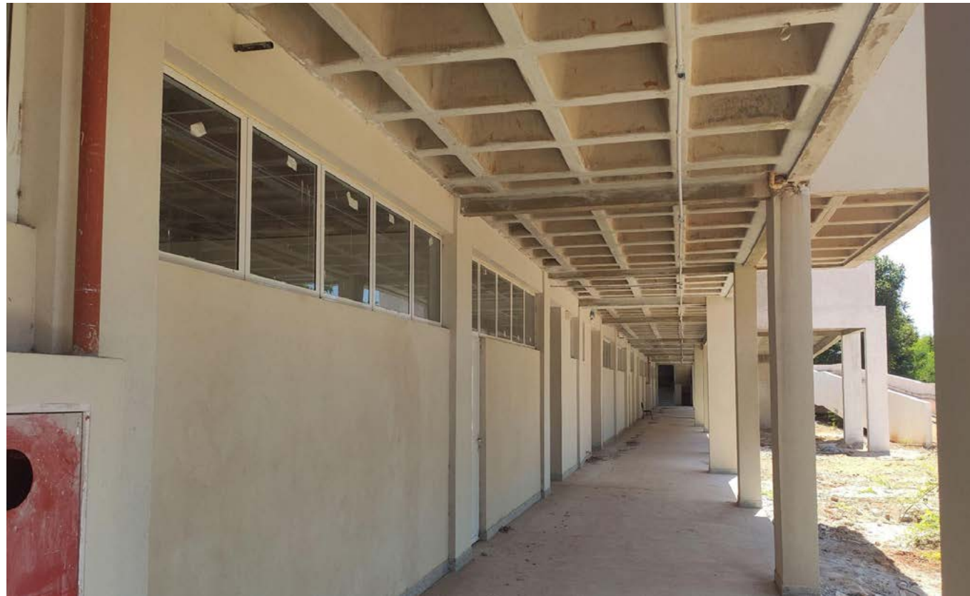
FIGURA 20: FACHADA POSTERIOR DO BLOCO DE AULAS 01
