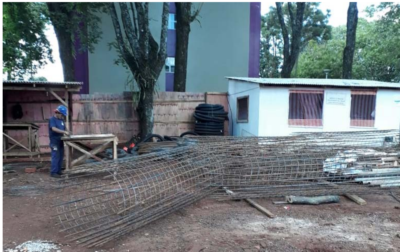
FIGURA 21: MOBILIZAÇÃO DO CANTEIRO DE OBRAS E INÍCIO DA MONTAGEM DAS FUNDAÇÕES DO BLOCO DE AULAS 02
